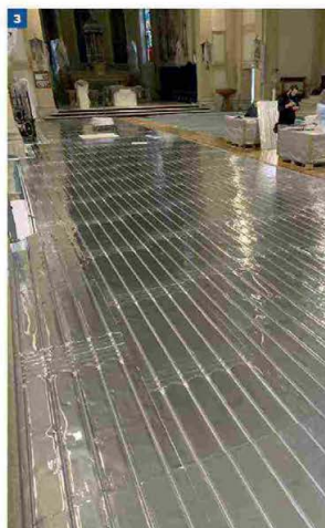
1 INTERNO della chiesa S. Michele Arcangelo di Salgareda (TV), PANORAMICA dell'impianto di riscaldamento installato all'interno delle due pedane 2 POSA della tubazione RDZ in multistrato 3 PANNELLO RDZ e-Dry completo di tubazioni
