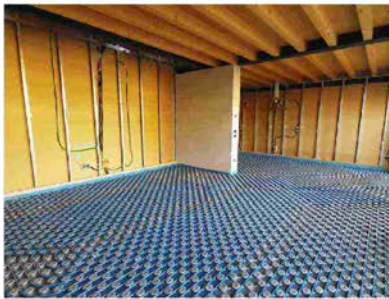
COVER HP è il pannello buonato di RDZ che, in quanto realizzato in polistirene sinterizzato con grafite, è in grado di fornire ottime prestazioni di isolamento termico anche con spessori ridotti
