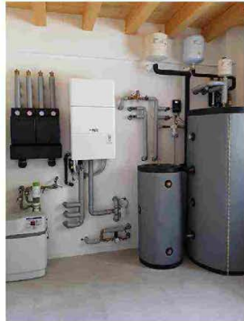
È STATA INSTALLATA una pompa di calore split della serie PDC di RDZ, con unità interna modello Wall 09 da fissare a parete
