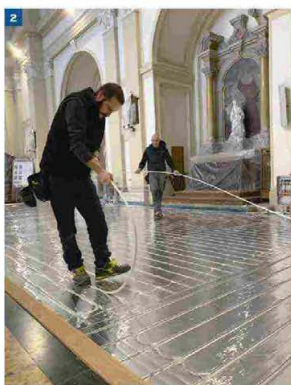
1 INTERNO della chiesa S. Michele Arcangelo di Salgareda (TV), PANORAMICA dell'impianto di riscaldamento installato all'interno delle due pedane 2 POSA della tubazione RDZ in multistrato 3 PANNELLO RDZ e-Dry completo di tubazioni
