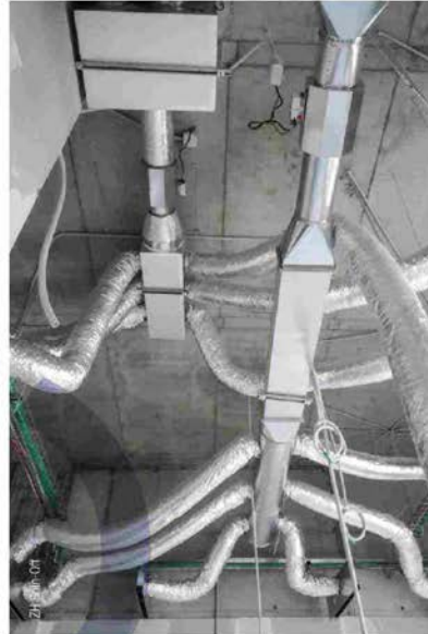
La rete di mandata è articolata in coppie di canalizzazioni dell'aria, a 12 °C e a 32 °C, immerse negli ambienti previa miscelazione mediate cassette VAV (ZH Spin-Off)
